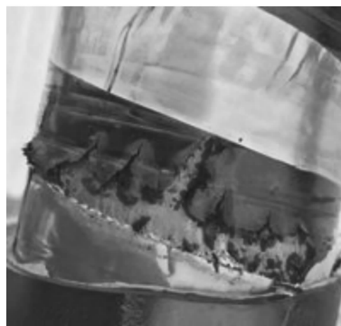
图 7 管母烧蚀痕迹
